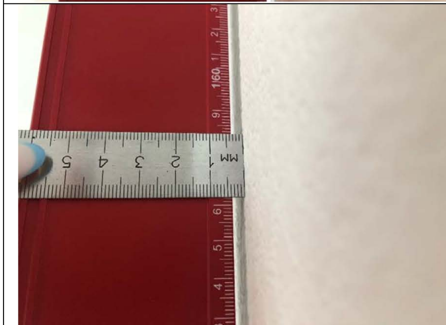
Фото №9. Измерение уровня стен гостиной в квартире.
