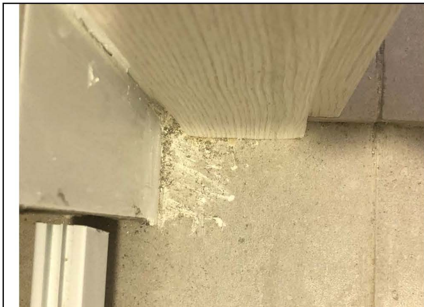
Фото №61. Загрязнение напольной плитки в ванне раствором.
