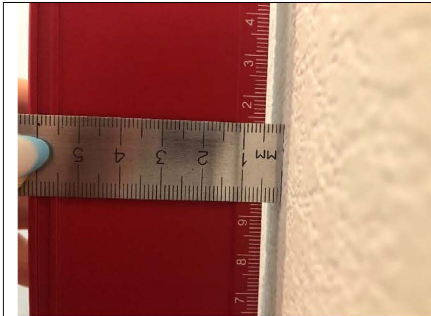
Фото №7. Измерение уровня стен коридора в квартире.
