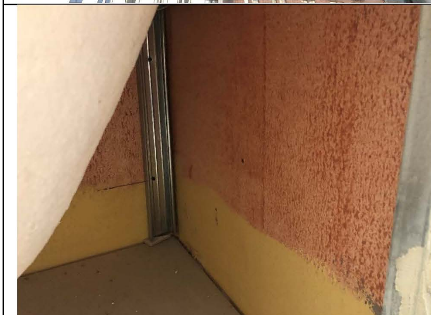
Фото №57. Отсутствует настенная плитка и затирка в ванне.
